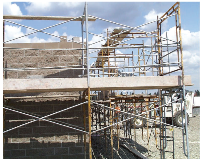
Andamio con protección apropiada
