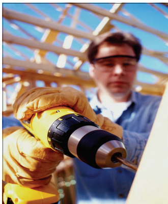
Uso de las herramientas eléctricas usando equipo de protección personal (PPE)
