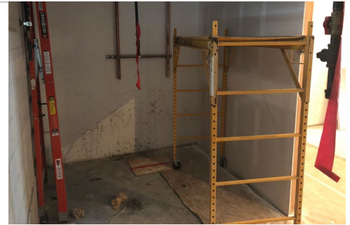
Foto 1: Andamio móvil de seis pies instalado en el pequeño cuarto de maquinaria. La puerta de la habitación está a la derecha del andamio.
