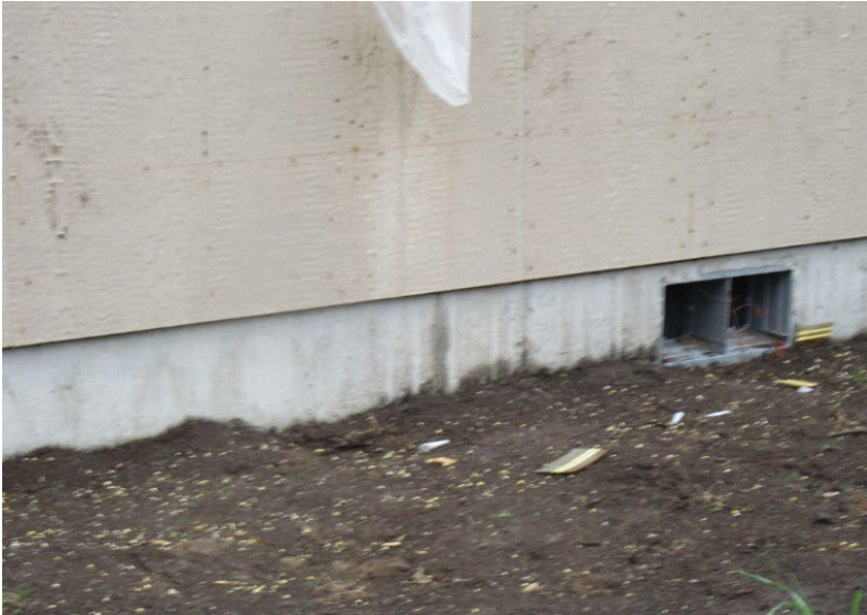
Fotografía 2. Tierra suave y dispareja en la que el instalador de estructuras colocó la base de la escalera de extensión.
