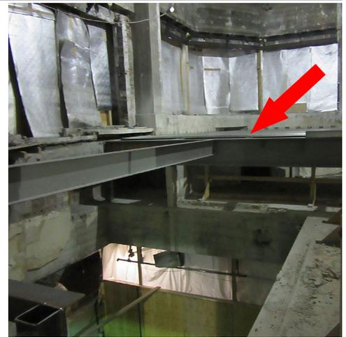
Участок, на котором рабочие устанавливали стальную балку над старой шахтой лифта. Сборщик металлоконструкций сидел на краю металлического настила, чтобы закрепить балку (показано стрелкой).
