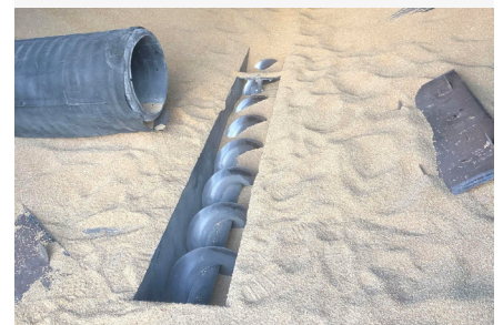
Incidente 2: El trabajador lesionado estaba moviendo grano con una pala alrededor del tubo del lado izquierdo. La transportadora de tornillo estaba cubierta con placas de acero durante el incidente.
