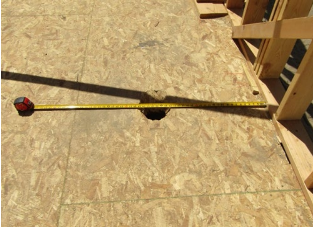
Fotografía 2. El agujero en el entablado de \frac{3}{4} de pulgada fue causado por el impacto de la cabeza del instalador de estructuras.
